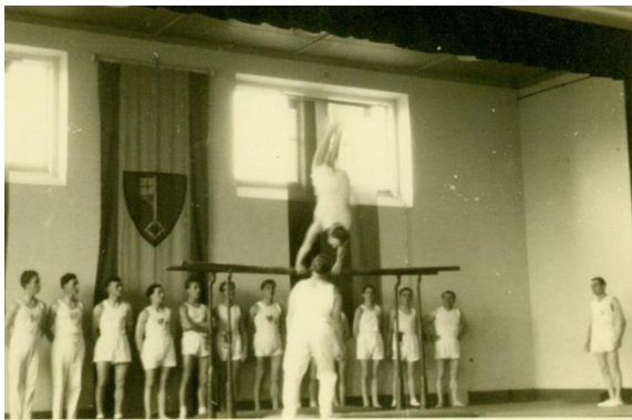
Schauturnen 1958 in der Turnhalle der Grundschule an der Sahlerstraße
